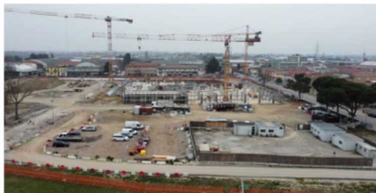
Il cantiere per la costruzione delle abitazioni del nuovo quartiere Novello
